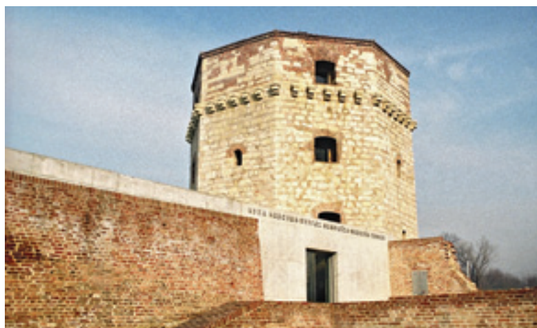
Slika 2. Kula i bedem sa ugrađenim aneksom, nakon završenih radova
